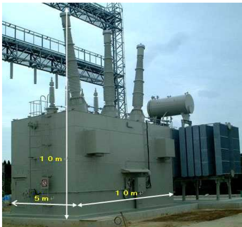
図-1 ルーフ・デルタ結線変圧器の外観（新型）
